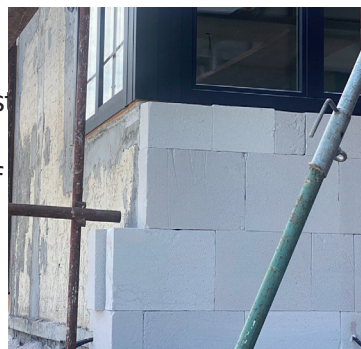
Innendämmung auf Mischmauerwerk
