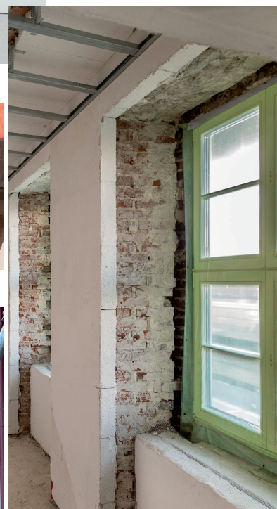
Innendämmung auf Mischmauerwerk
